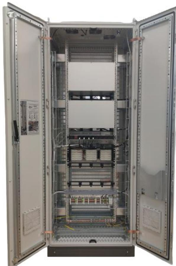
Рисунок 49 – Внешний вид шкафа типа ШНЭ 2703 (вид сзади с открытыми дверями)
