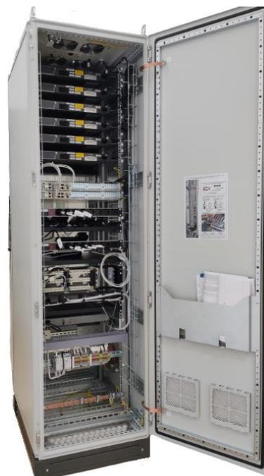
Рисунок 59 – Состав шкафа типа ШНЭ 2704 (вид сзади)
